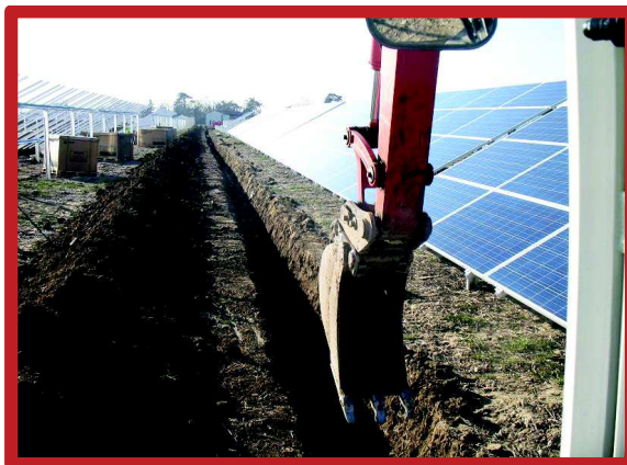
- Tranchées entre les rangées de tables photovoltaïques -
