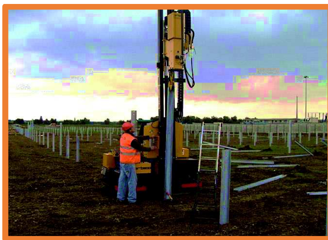
- Exemple de fondation type pieux -
