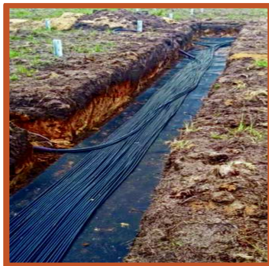
- Photo-illustration d'une tranchée avec réseau de câbles - - Mémoire en réponse au PVS -
